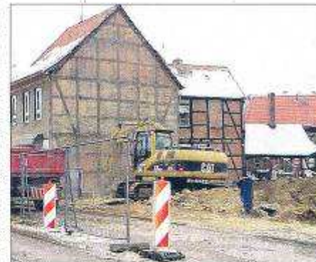
In der Warener Straße wurden jetzt zwei weitere marode Häuser abgerissen. Hier soll ein neues Wohnhaus entstehen.
